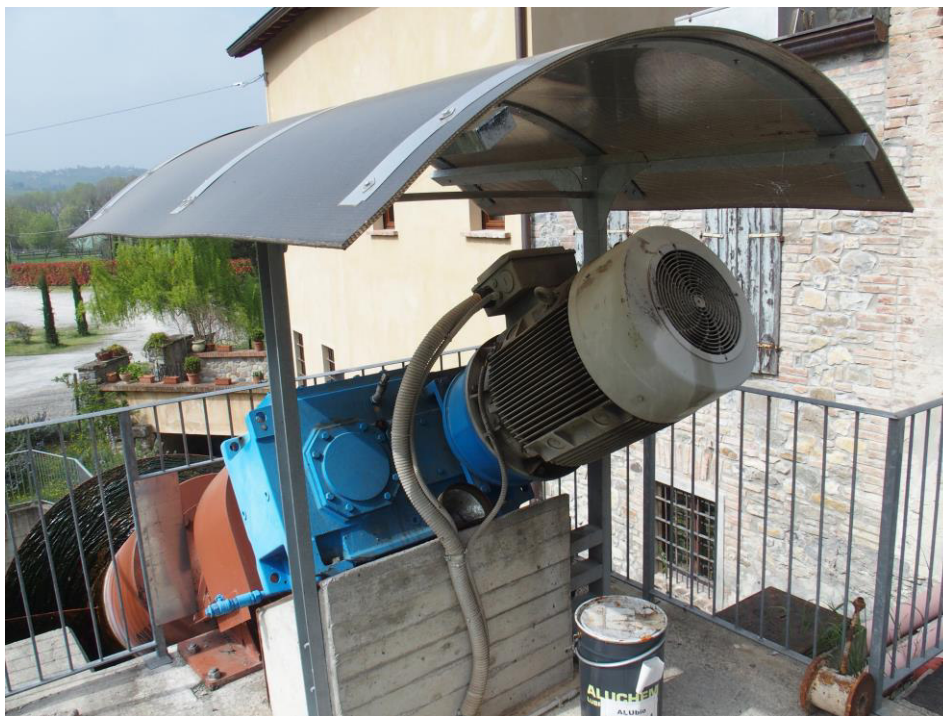
Foto 4.2 – Particolare del generatore; in questo caso la macchina è semplicemente coperta da una tettoia e non è stato previsto un vano tecnico di alloggiamento.
