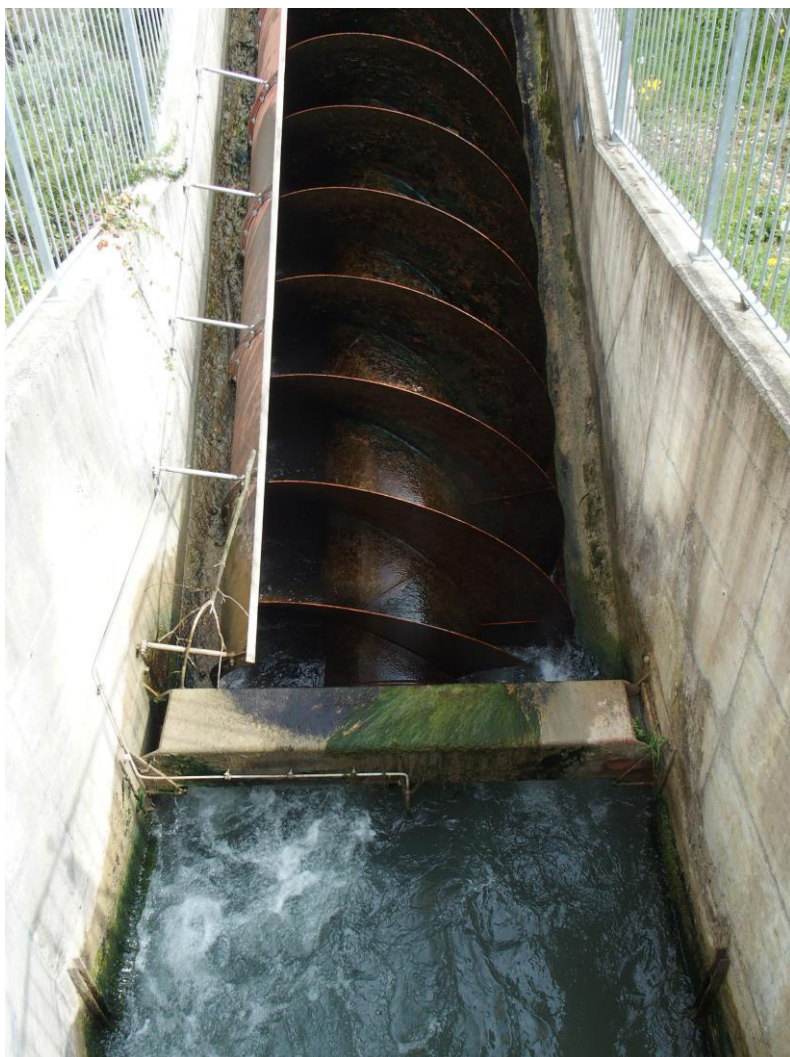
Foto 4.3 – Particolare del punto di scarico dove l'acqua esce dalla coclea e cade nella vasca di raccolta.
