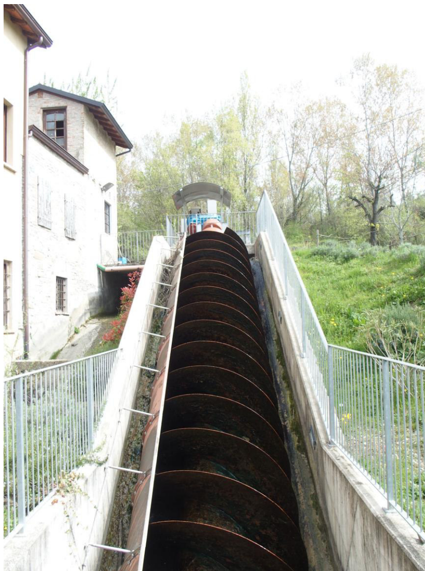
Foto 4.1 – Coclea installata su un salto idraulico esistente presso un mulino ristrutturato.
